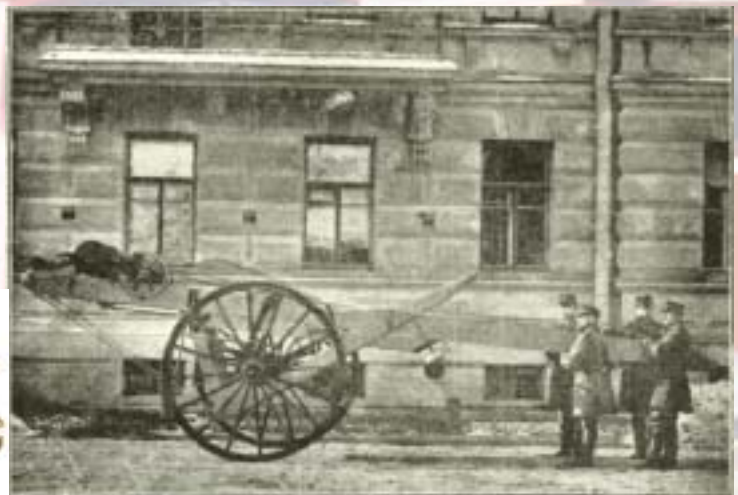
Лестница снятая с передка.
